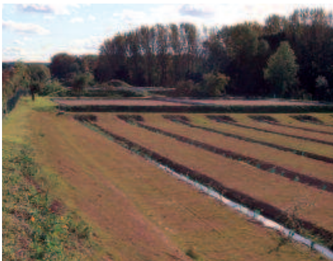
Les eaux usées passent par trois bassins filtrants dans lesquels sont plantés les roseaux. Ce système reprend le cycle naturel de l'épuration de l'eau mais en mode optimisé.
